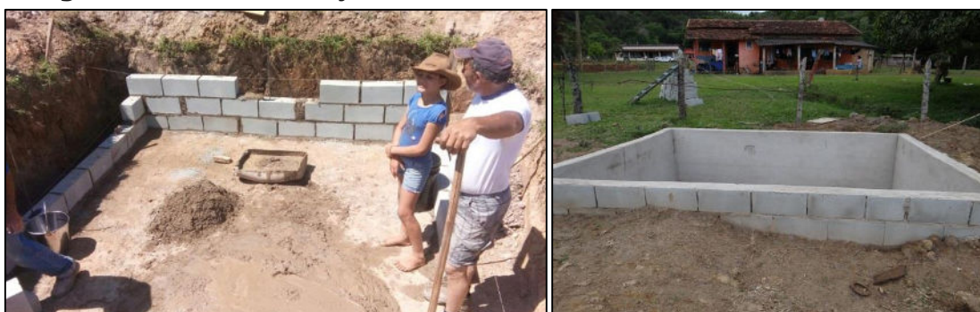
Imagens 1 e 2 – Construção da alvenaria cimentada.
