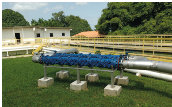
Instalación catalizador Solavite CERPA Cervejaria Paraense
