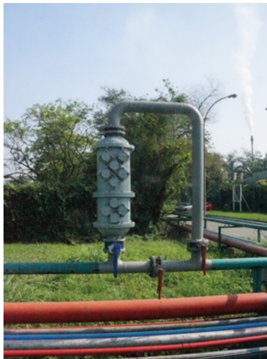
■ Bayer CD-20 Red de suministro de agua 2
