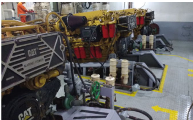
Instalación catalizador Solavite Motor en Remolcador
