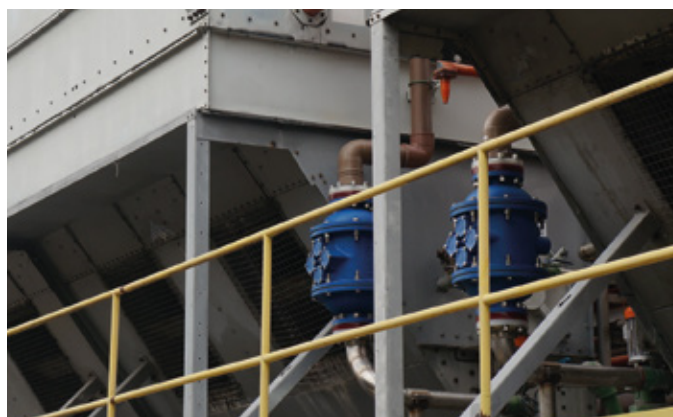
Instalación catalizador Solavite CERPA Cervejaria Paraense
