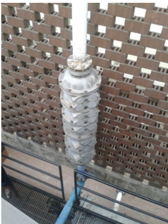
Instalación Catalizador Solavite Hydro en torres de enfriamiento y calderas en Marina Nacional PEMEX
