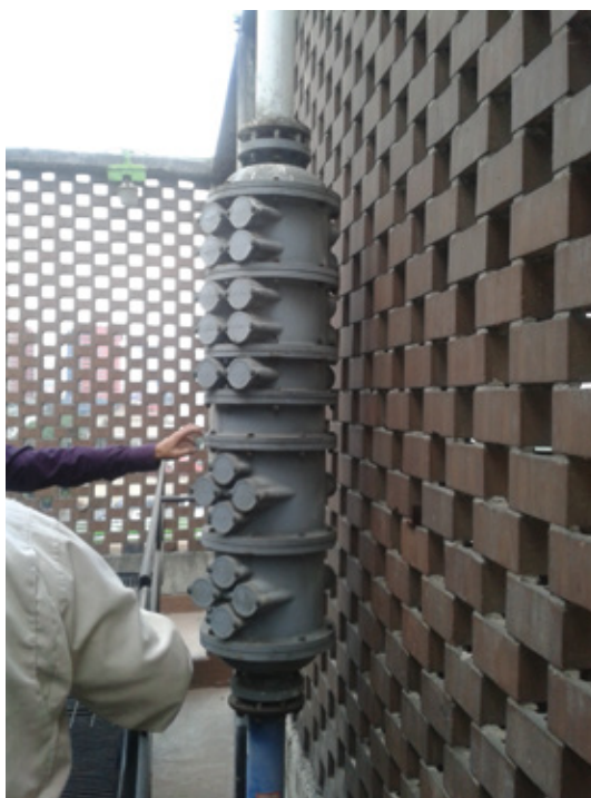
Instalación Catalizador Solavite Hydro en torres de enfriamiento y calderas en Marina Nacional PEMEX
