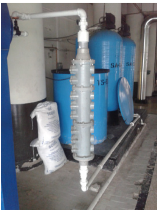
Instalación Catalizador Solavite Hydro en torres de enfriamiento y calderas en Marina Nacional PEMEX
