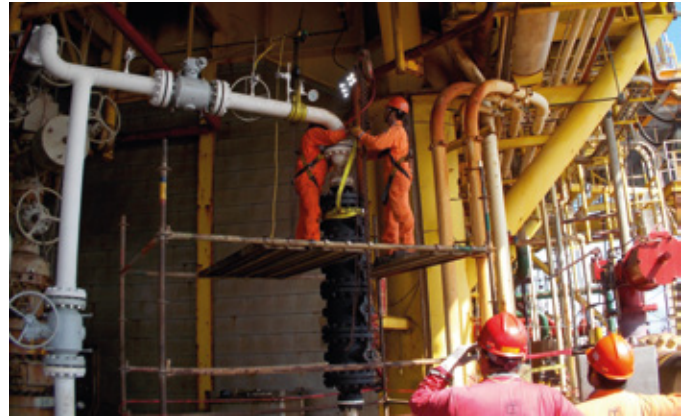
Instalación catalizador Solavite activo de producción Cantarell
