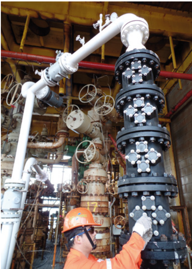
Instalación catalizador Solavite Oil&Gas
