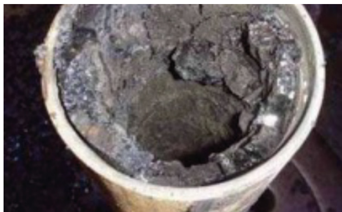
Ejemplo de incrustación carbonatos.
