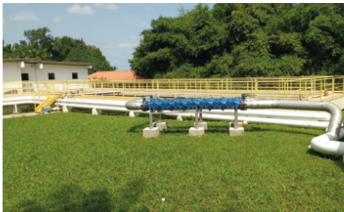
Instalación catalizador Solavite CERPA Cervejaria Paraense
