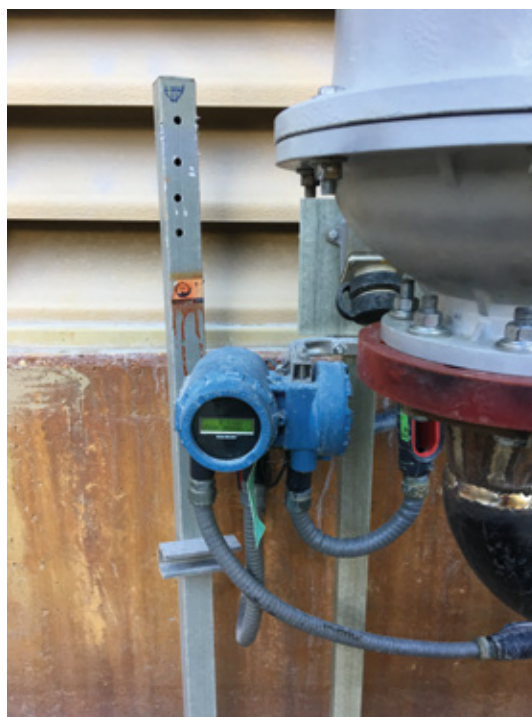
Instalación flujometro
