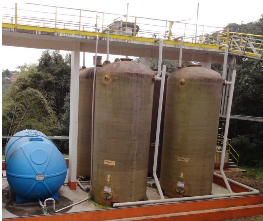
Figura 17 - Reatores biológicos e tanque de equalização
