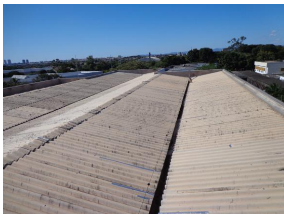
A) Visão geral da cobertura
