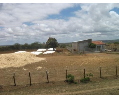
Figura 8: Construção de silo nas Lajes em Poço Verde/SE.
